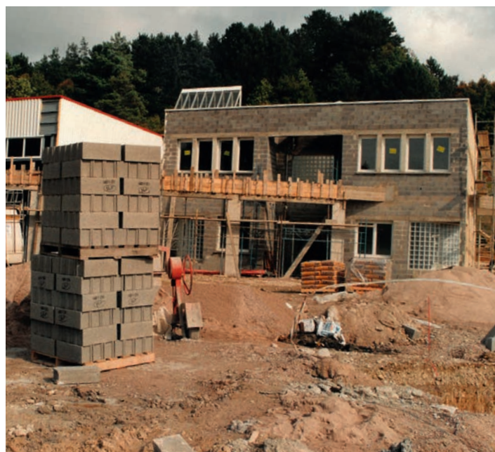
1995, les locaux du Cerfav en construction - © Cerfav
